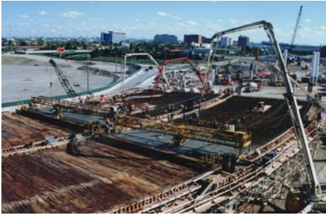
Figure 4 – Deck pour in progress
